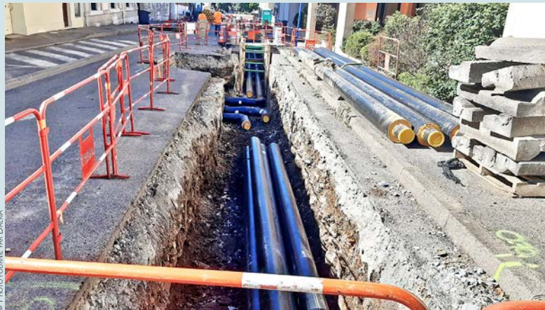
Le réseau chaleur de Saint-Chamond s'étendra sur 17 km de canalisation.
